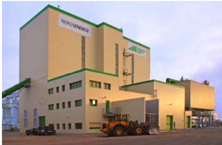
Inbetriebnahme im September 2008
